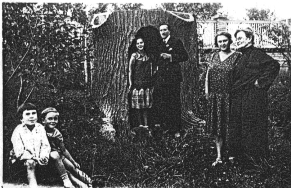
U betonového pařezu
